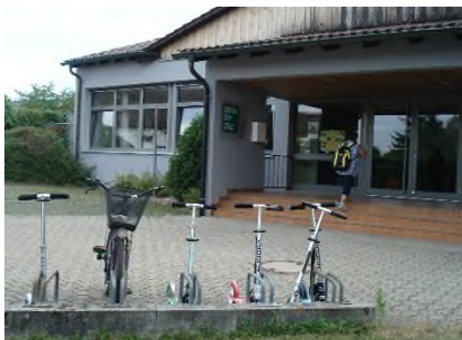
Haupteingang der Schule mit Abstellanlagen im Vordergrund
