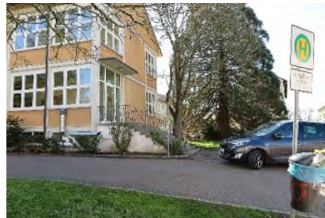
Eingang an der Westseite
