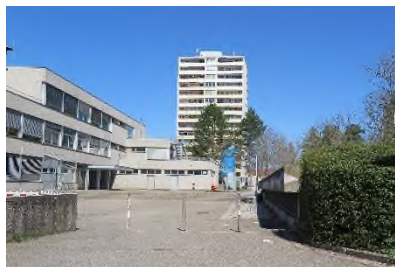
Zugang auf den Schulhof
